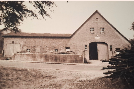
Hauptstraße 54 Foto: Liselote Hagen
