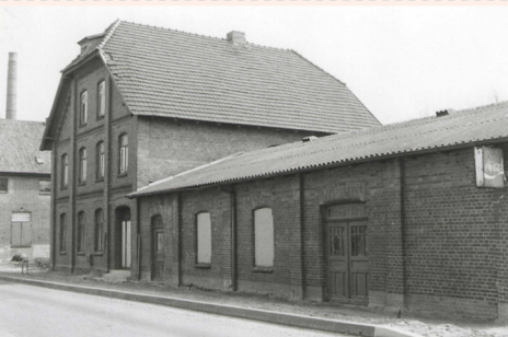
Wirtschaft Martens mit Tanzsaal vor Instandsetzung (1980) Hauptstraße 29. Foto: Oliver Ihlow
